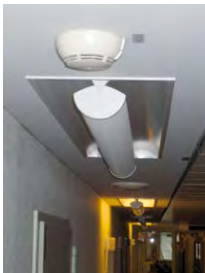
Slimnīcas gaitēju apgaismojuma regulēšana ar sensoru palīdzību
