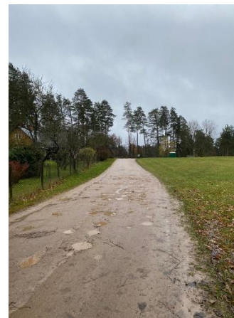
1.attēls Piebraucamais ceļš uz kapsētu (Lokālpilnojumā teritorijā)
